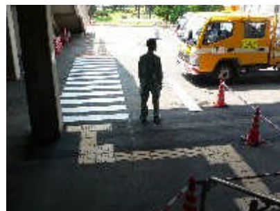
センター入口誘導ブロック
